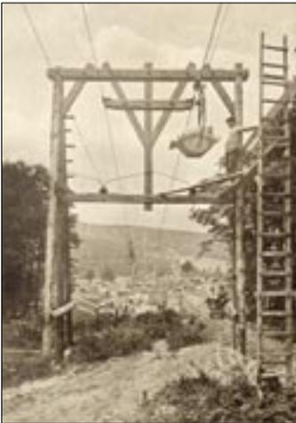
Links Wasserleitungsbau im Gütenbachtal, rechts Druckentlastungskammer Mauer.
