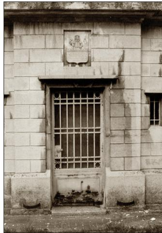
Die beiden Wasserkammern der 2. Hochquellenwasserleitung in Mauer, Übergangskammer und Druckentlastungskammer, waren verhältnismäßig klein gehalten. Der Bau des großen Wasserspeichers im Lainzer Tiergarten erfolgte erst 1935 bis 1937.
