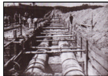
Baustelle einer Dükerleitung im Zuge der Wasserleitungsführung.
