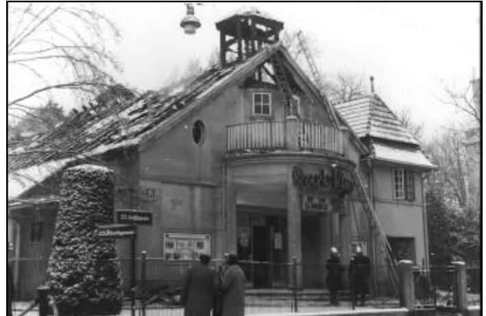
Am 10. Jänner 1966 wurde das Kino durch einen Brand so beschädigt, dass der Betrieb für immer eingestellt werden musste.
