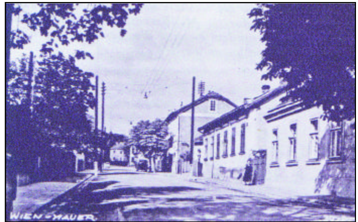
Blick in die Peterlinigasse von der Speisinger Straße aus. Das zweite Haus rechts war das ehemalige Pfarrheim.
