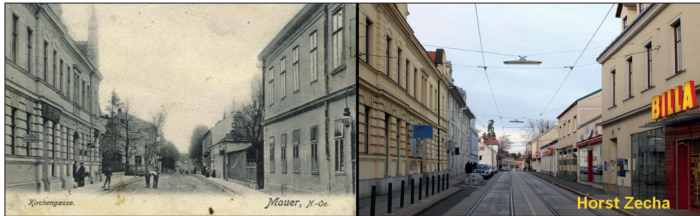
Geßlgasse 19. Links die alte Ansicht, rechts Aufnahme von 2011.
