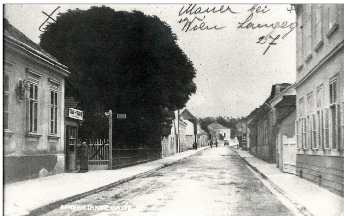
Die untere Maurer Lange Gasse Blick zur Kunkegasse in Höhe der Hausnummer 27.
