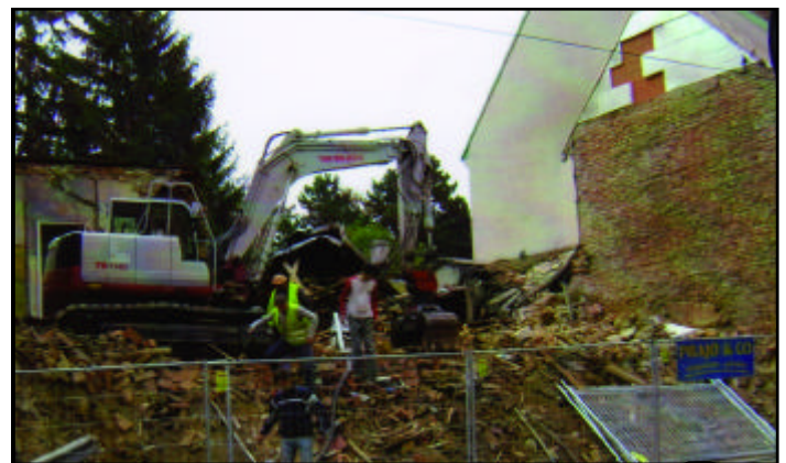
Der Tag nach dem nächtlichen Abbruch: Sa. 8.9.2007. Foto: Helmut Neumann.
